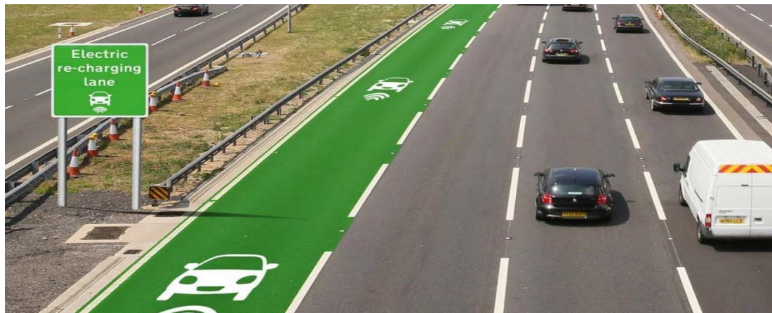
Slika 1. Prikaz punjenja električnih vozila tijekom vožnje
