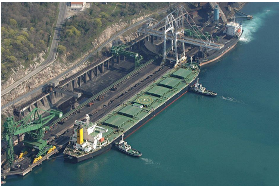
Slika 6. Terminal za rasuti teret u Bakru
