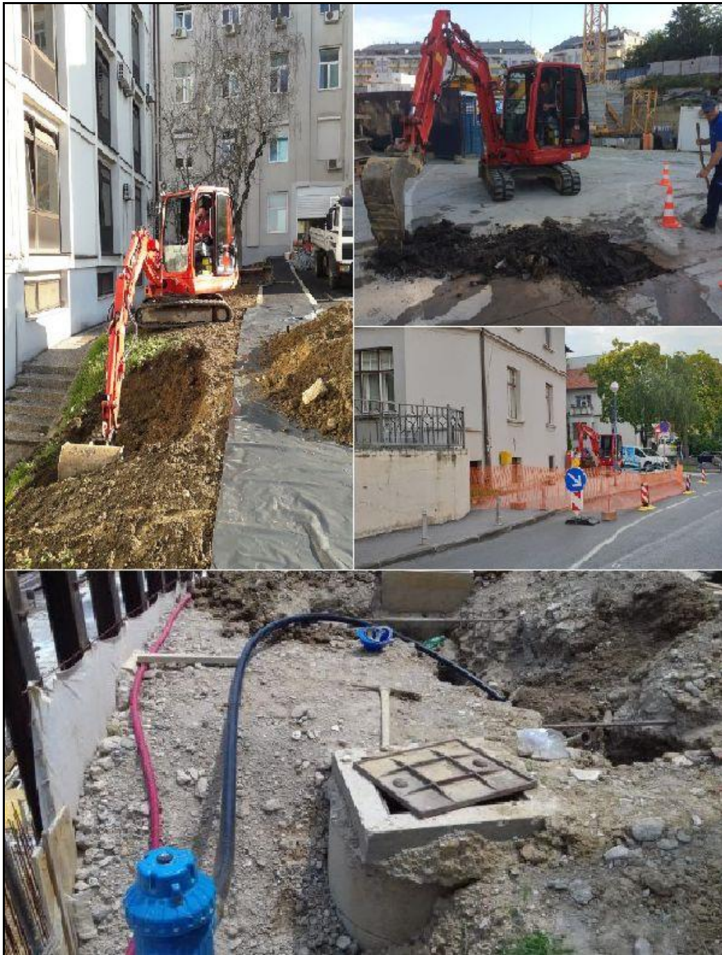
Slika 17: Sanacije propuštanja cjevovoda i priključaka
