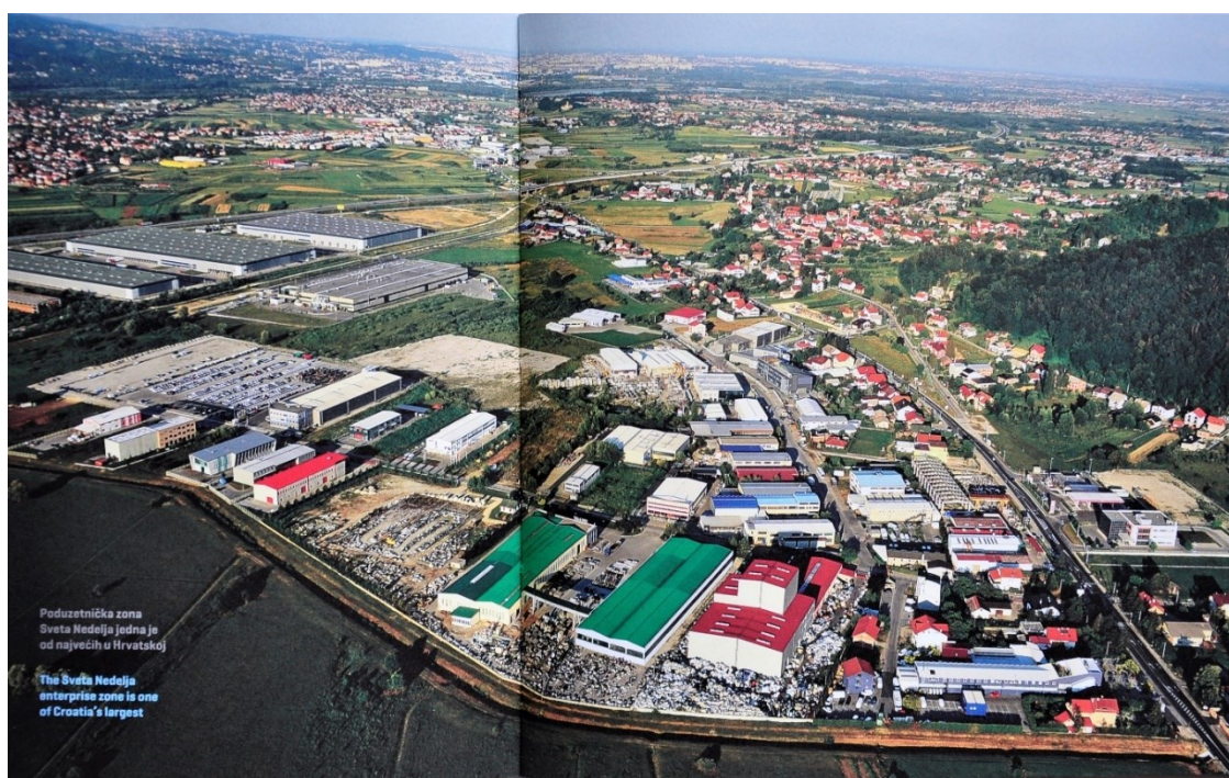
Slika 9. Tvornice unutar poslovne zone Sveta Nedelja
