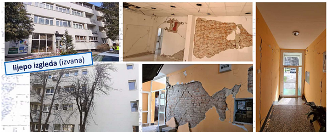
Slika 20. Višestambena zgrada u Petrinji, Trg Franje Tuđmana
