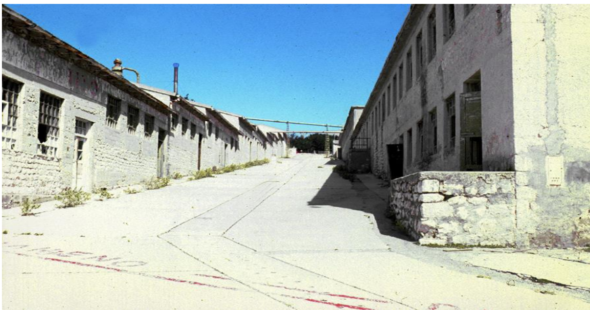
Slika 11 Zatvorske zgrade na prostoru nekadašnjeg logora
