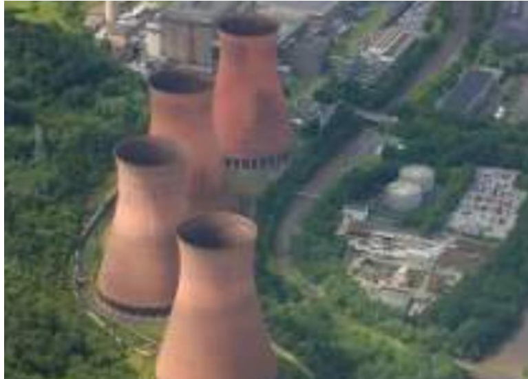
Slika 9: Ironbridge elektrana na biomasu, Ujedinjeno Kraljevstvo
