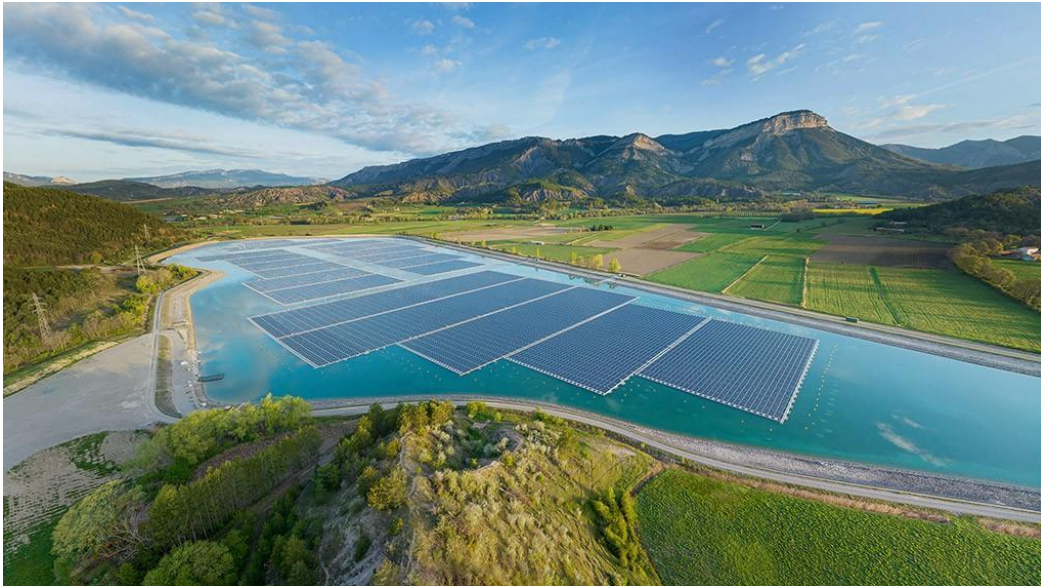
Slika 8. – Lake Lazer solarna elektrana
