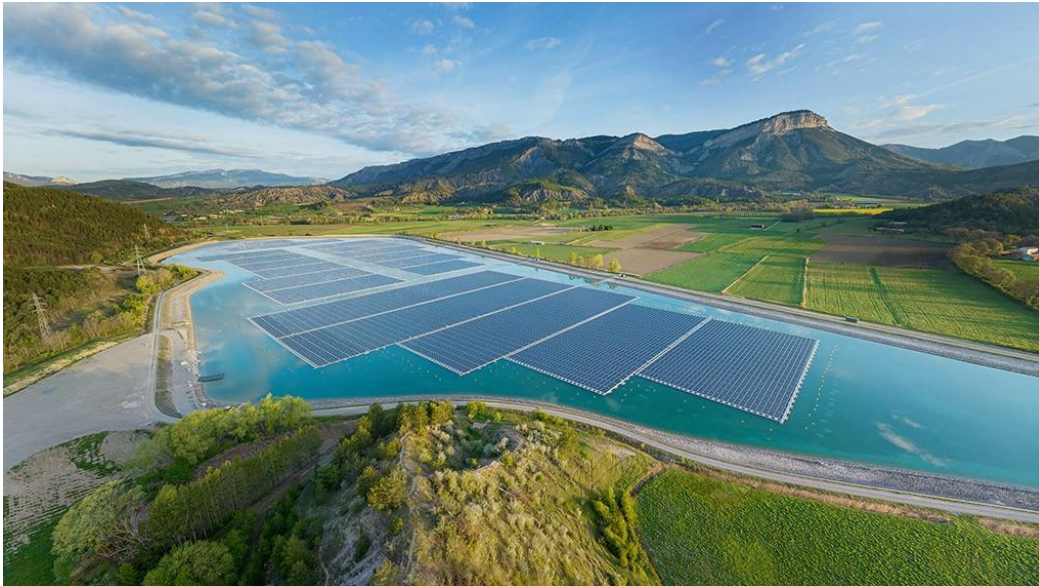
Slika 8. – Lake Lazer solarna elektrana
