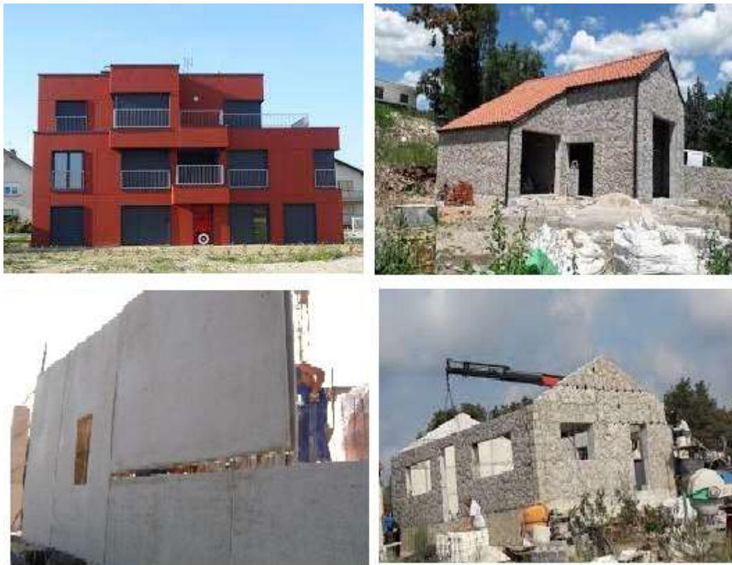
Slika 22. Montažne kuće od betona
