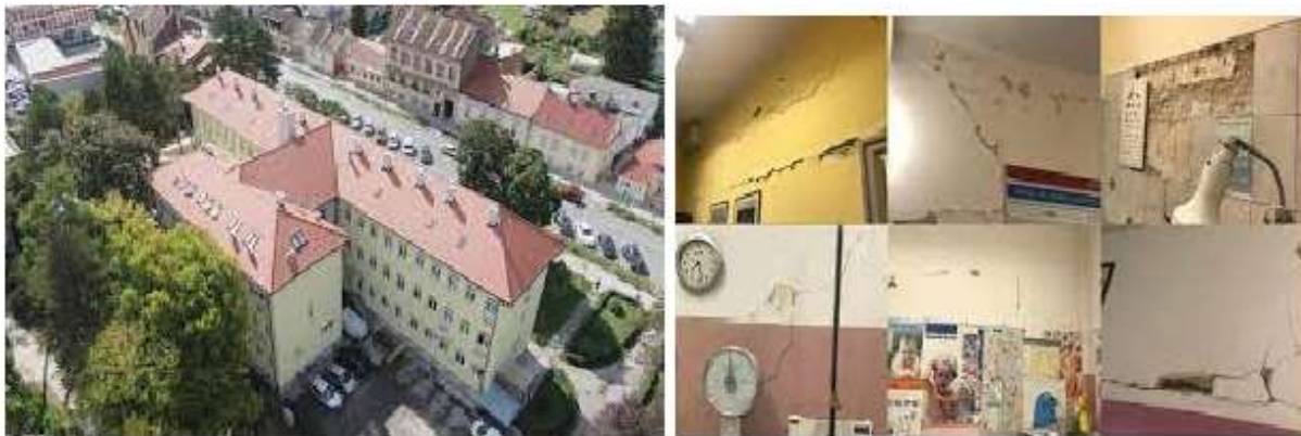
Slika 17. Dom zdravlja Sisak nakon energetske obnove i nakon potresa
