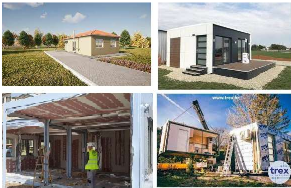
Slika 23. Modularne kuće čelične konstrukcije
