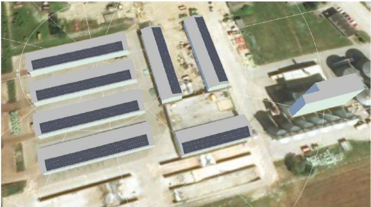
Slika 4 Izgled fotonaponske elektrane Božjakovina d.o.o.
