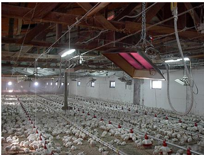
Slika 8. Primjena infracrvene grijalice u peradarstvu
