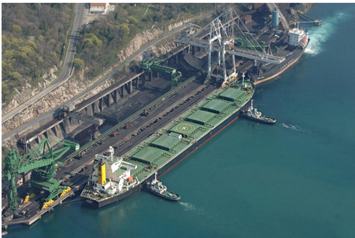
Slika 6. Terminal za rasuti teret u Bakru
