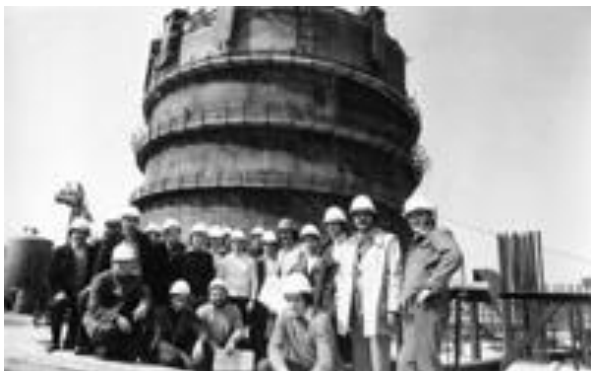
Slika 3: Montaža reaktorske zgrade Nuklearne elektrane Krško 1975. godine
