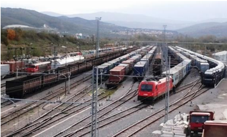
Slika 20. Željezničkikolosjeci u Luci Kopar
