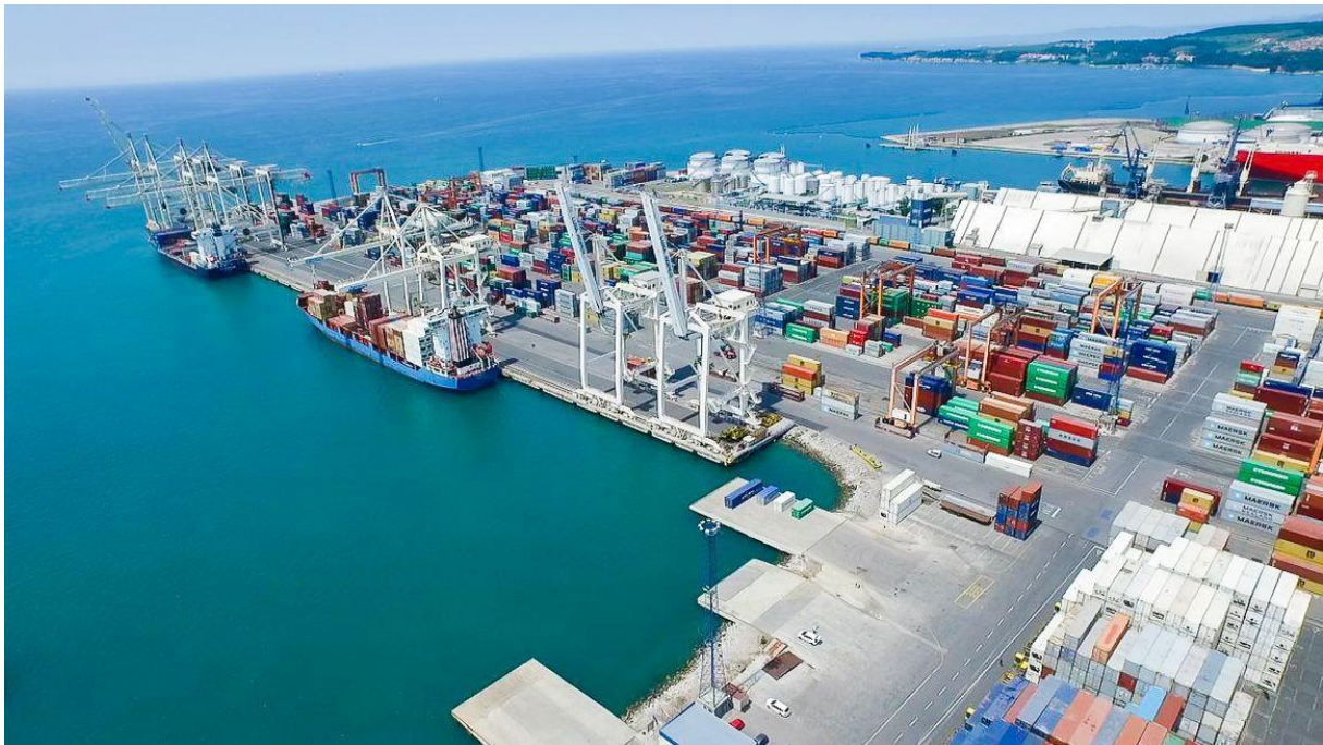
Slika 18. Kontejnerski terminal luke Kopar
