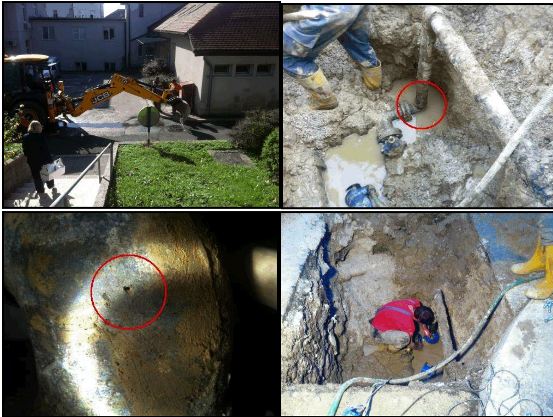
Slika 16: Primjer sanacije propuštanja hidrantskog voda
