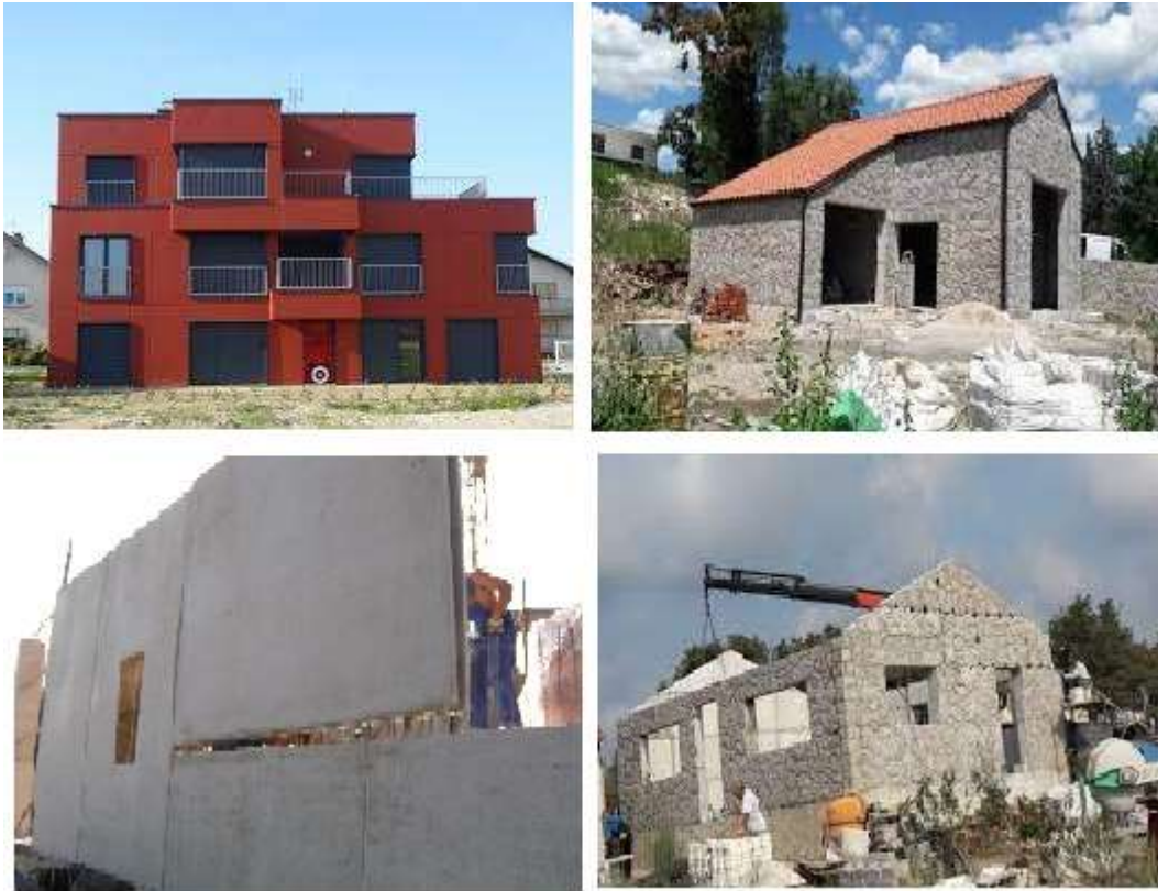
Slika 22. Montažne kuće od betona
