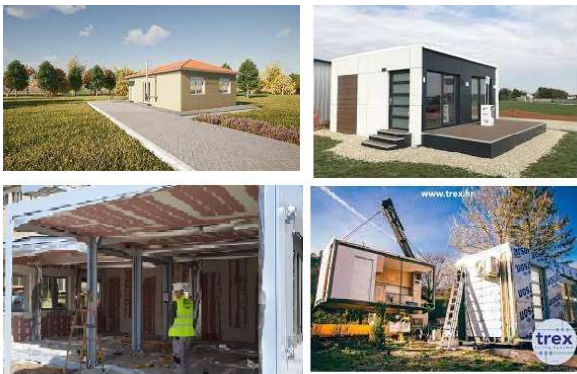
Slika 23. Modularne kuće čelične konstrukcije
