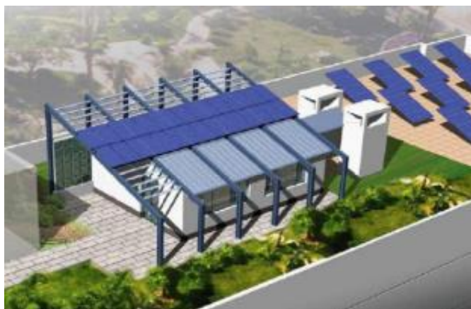
Slika 3. Solarni klimatizacijski sustav instaliran na krovu zgrade
