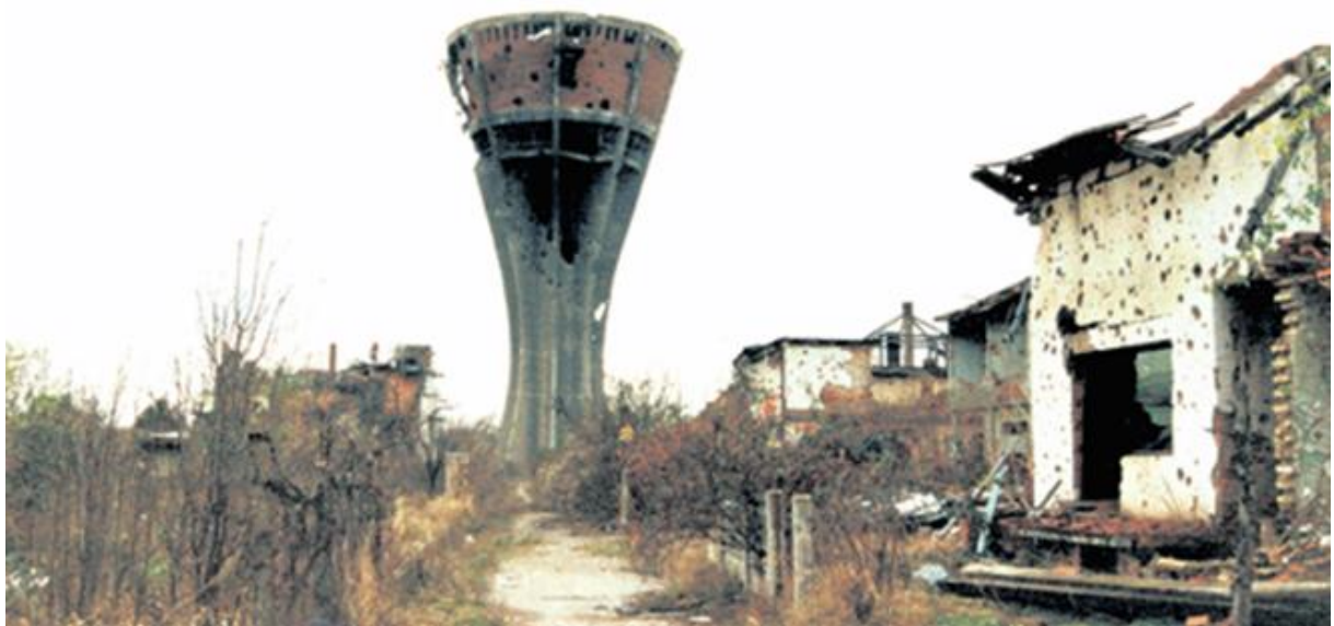
Slika 8 Vukovarski vodotoranj nakon rata
