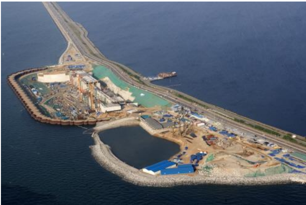
Slika 8: Plimna elektrana Sihwa Lake, Južna Koreja
